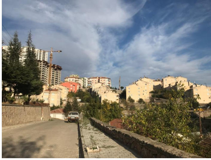
Foto 4: Yazıcıoğlu bölgesinde yıkılmayı bekleyen kooperatif konutları
