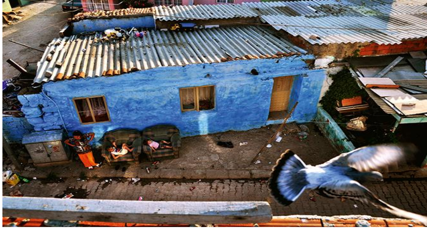
Foto 1. Fevzipaşa Mahallesi Üstten Görünüm
