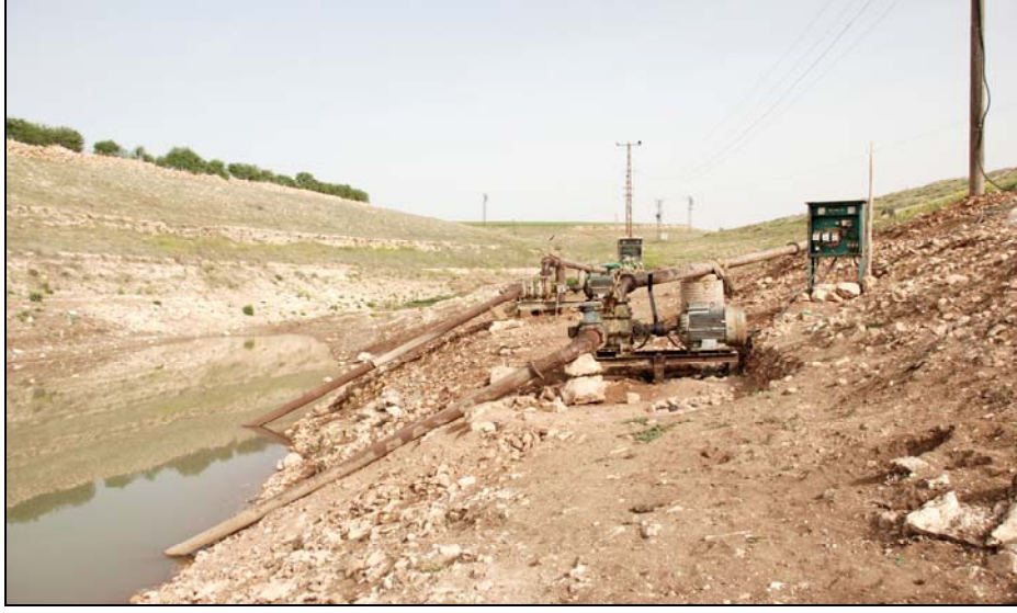
Foto 2: Şanlıurfa iline bağlı Hilvan ilçesinin Faik köyünde bir sulama tesisinin görünüşü
